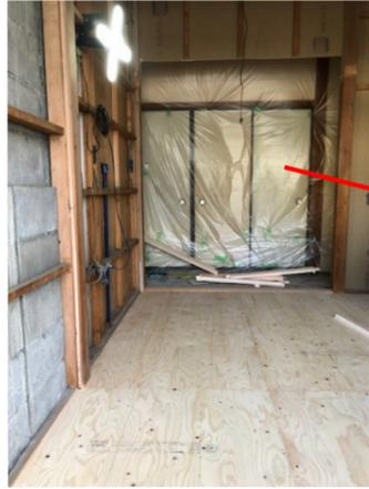
畳の6畳間を床張り、押入れをクローゼットへ変えました。壁を剥がしたところ断熱材が劣化、厚い品に入替ました。入口は障子を片引きの引き戸にし、違和感を軽減しました。北向きの部屋なので、保温性を重視、北の掃き出し窓には内窓を設置しました。
