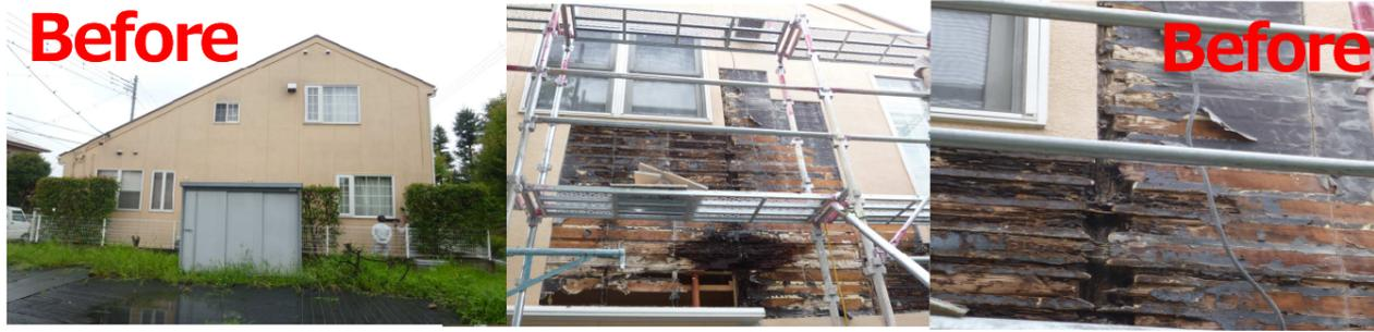
シロアリ被害に遭われたお客様宅、雨漏れ工事から発見されたシロアリ！梁や柱がスカスカな状態でした。大規模なシロアリ駆除及び改修工事が終了しお客様も安心されました。
